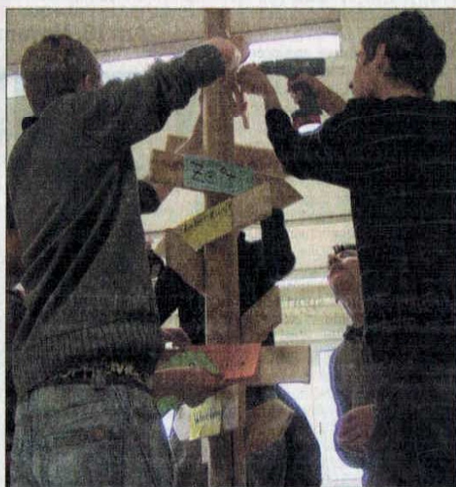
Einen Wegweiser, der helfen soll, Jugendaustausch zu vereinfachen, bauten Jugendliche in Neuenkirchen. Foto: A. Meyer
