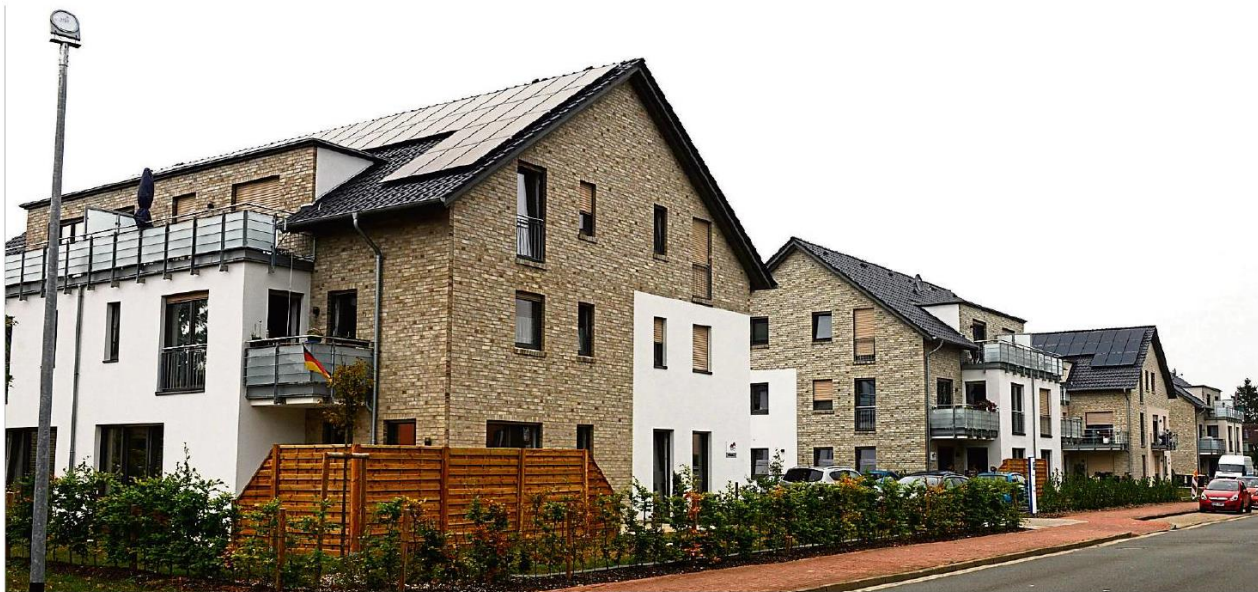
Bezahlbarer Wohnraum: Die Baugenossenschaft Landkreis Osnabrück hat an der Artlandstraße in Quakenbrück Wohnungen errichtet, für die es eine große Nachfrage gibt.
