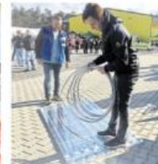
Knifflig: Den Schlauch für eine Fußbodenheizung verlegen.
